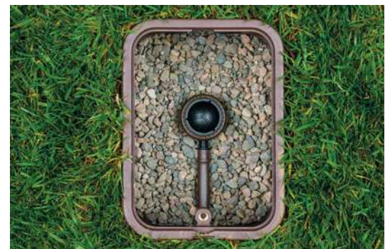
Válvula de Descarga Automática Instalada
