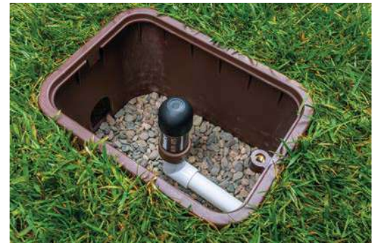
Válvula de Ventosa de Aire/Vacío Instalada
